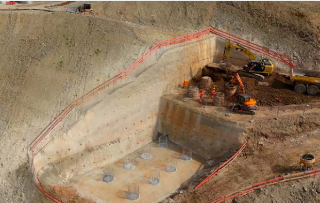
Mit Mikropfählen TITAN rückverankerte Spritzbetonwände schützen die Baugruben der Brückenpfeiler.
