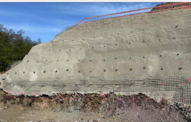
Mikropfähle TITAN und Bewehrungsmatten mit Spritzbeton.
