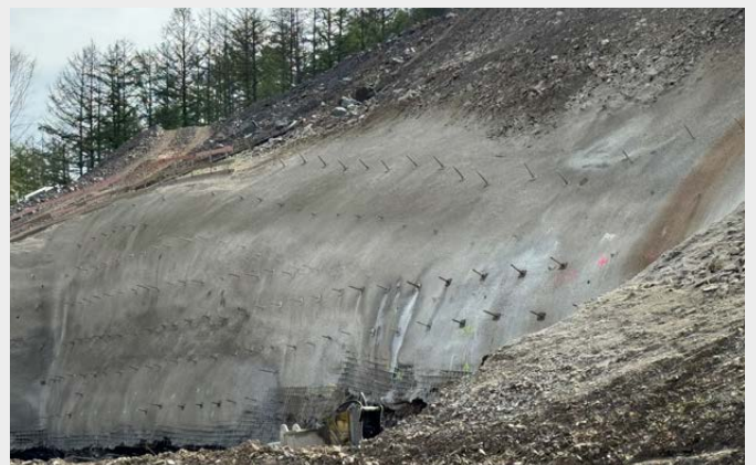
Auch an schwer zugänglichen Stellen konnte das Selbstbohrsystem einfach eingebaut werden.
