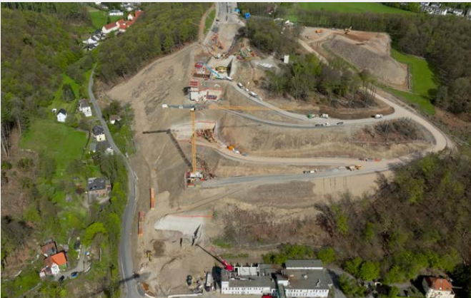
Der Blick von oben auf die Großbaustelle in Fahrtrichtung Dortmund.
