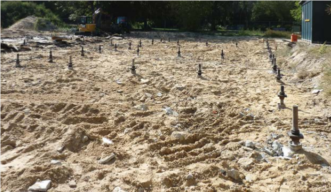
Im Zuge der Gründung einer Bodenplatte für den Kita-Neubau in Zehdenick wurden Mikropfähle TITAN 73/56 verwendet.
