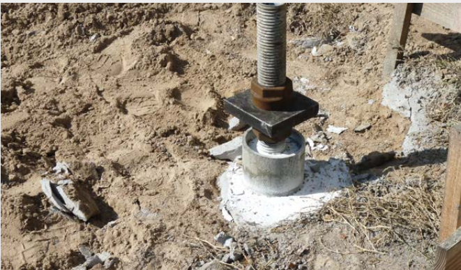
Entsprechend den Anforderungen des gegebenen Untergrundes sind Kreuzbohrkronen zum Einsatz gekommen.
