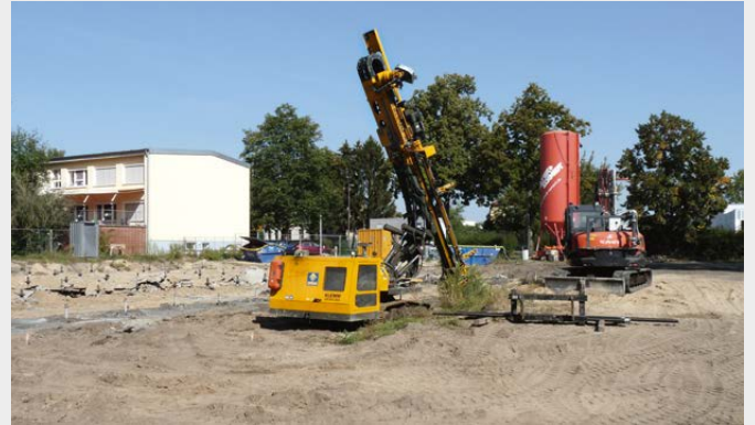
Der Einbau hat mit Hilfe eines Bohrwagens stattgefunden, der die Mikropfähle TITAN zielgenau installierte.
