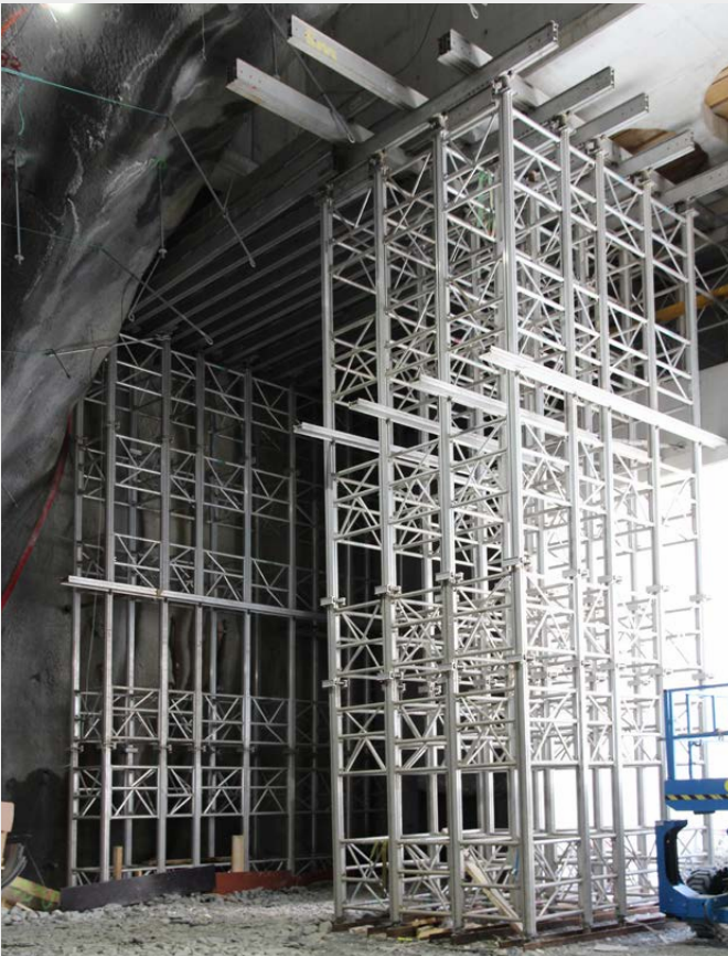
Das Alu-Schalungsgerüst TITAN wurde zur Unterstützung der Belüftungsschächte eingesetzt.
