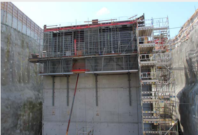
Boxer Climbrac Auto, hydraulische Gleitschalung für hohe Wände.
