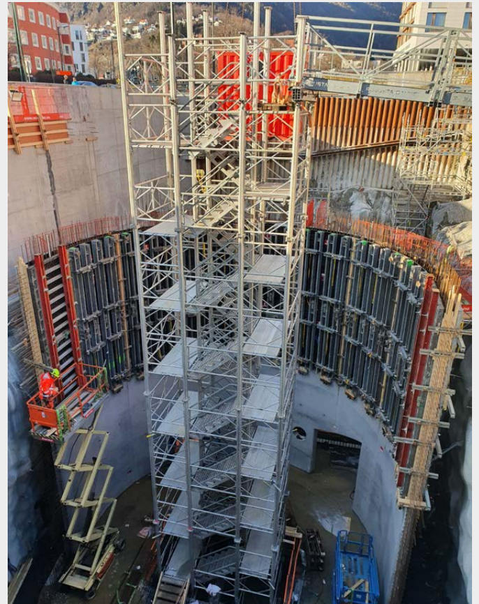
Treppenturm TITAN mit Robusta-Gaukel-Multi-Steg als Baustellenzugang.
