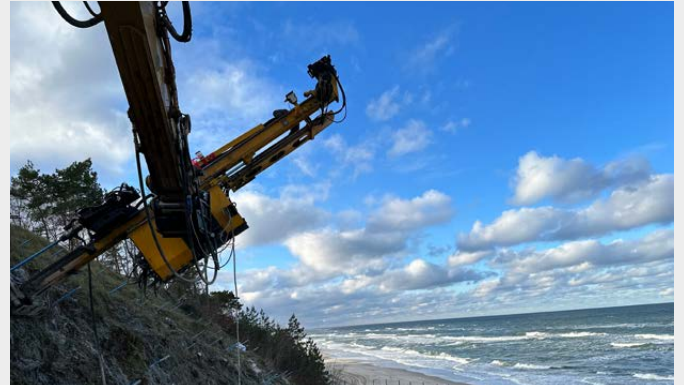
Trotz der schwierigen Hanglage konnten die Bodennägel zuverlässig mit kleiner Gerätetechnik eingebaut werden.
