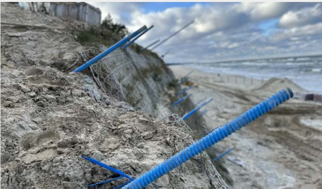
Mikropfähle TITAN 40/27 als Bodennägel mit 30° Neigung.
