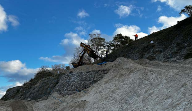
Böschungssicherung des Steilhangs mit Mikropfählen TITAN als Bodennägel.
