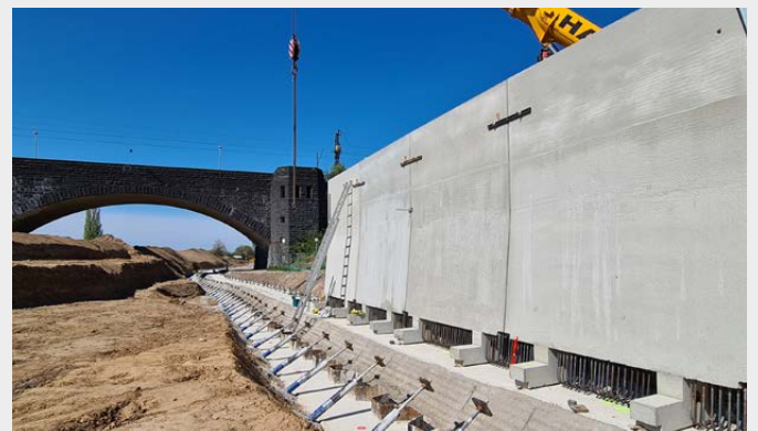
Das Setzen der Deichmauer erfolgte in Fertigteil-Bauweise.
