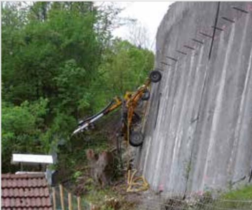
**Risanamento dell'ancoraggio di un muro di spalla**
