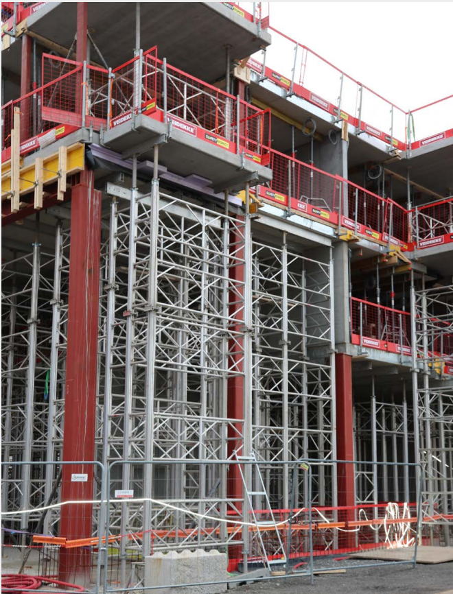
Alu-Schalungstürme TITAN stützen Balkone auf fünf Ebenen und bieten eine hohe Tragfähigkeit und Steifigkeit.
