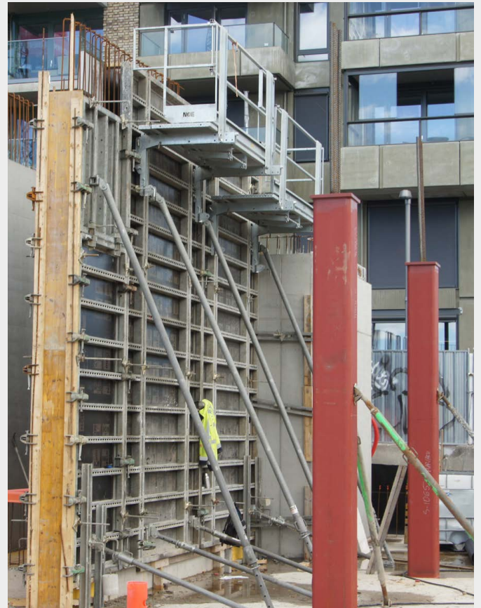
Richtstreben TITAN RS an einem NOE Wandelement.
