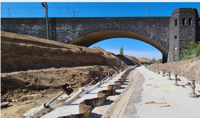
Für die Rückverankerung der Spundwand und die Gründung der Deichmauer wurden Mikropfähle TITAN eingesetzt.
