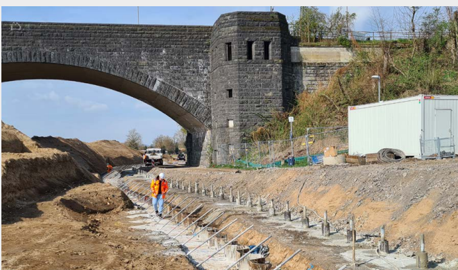
Trotz der beschränkten Höhe unterhalb der Brücke konnte die Bohrleistung problemlos aufrechterhalten werden.
