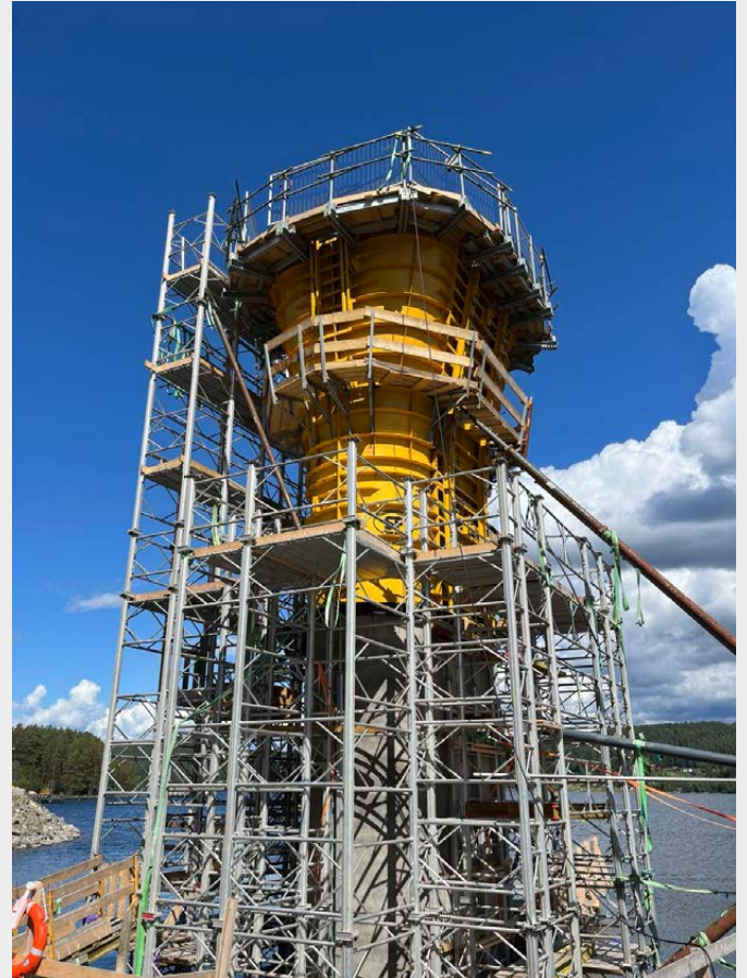
Alu-Schalungsgerüst TITAN Treppenaufstieg, Säulenschalung und Stahl-Richtstreben TITAN BKS.
