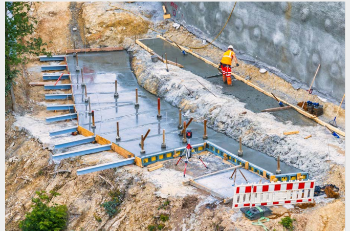
Spritzbetonsicherung und Gründung der Bergstation.
