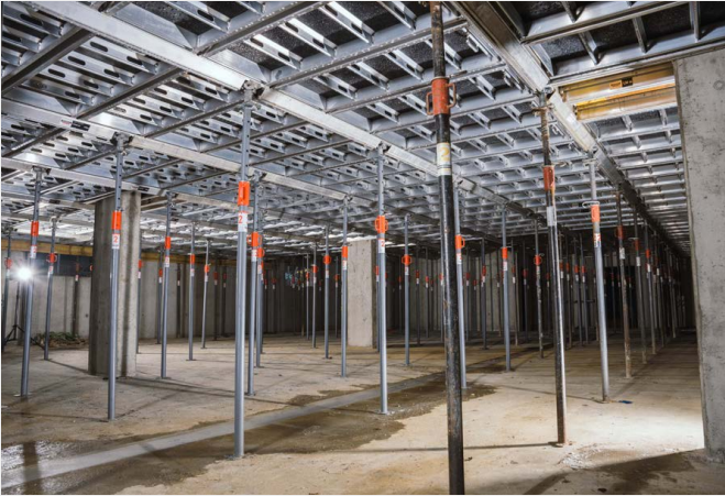
Blick auf die von unten montierte Alu-Deckenschalung TITAN HV mit Combi Paneelen TITAN HV 150.
