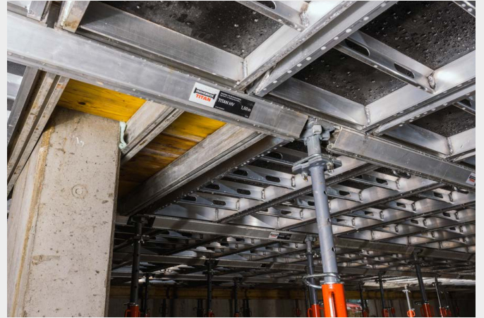
Die Alu-Deckenschalung TITAN HV passt sich flexibel an Störstellen, wie z.B. Säulen, an.
