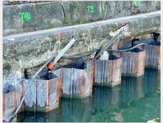
Bestehende Kaimauer mit installierten Mikropfählen TITAN.
