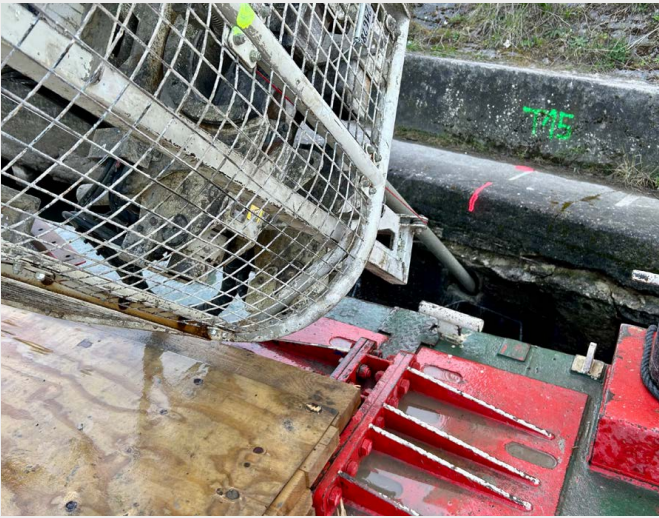
Installation der Mikropfähle vom Ponton aus.
