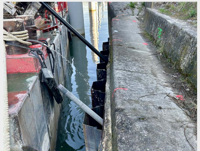
Der Mindestabstand zwischen dem Ponton und der Kaimauer musste eingehalten werden.
