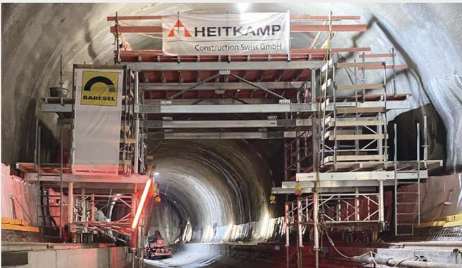
Zur Vervollständigung der Tunnel-Außenschale wurde ein Nachbearbeitungswagen von Ischebeck eingesetzt.
