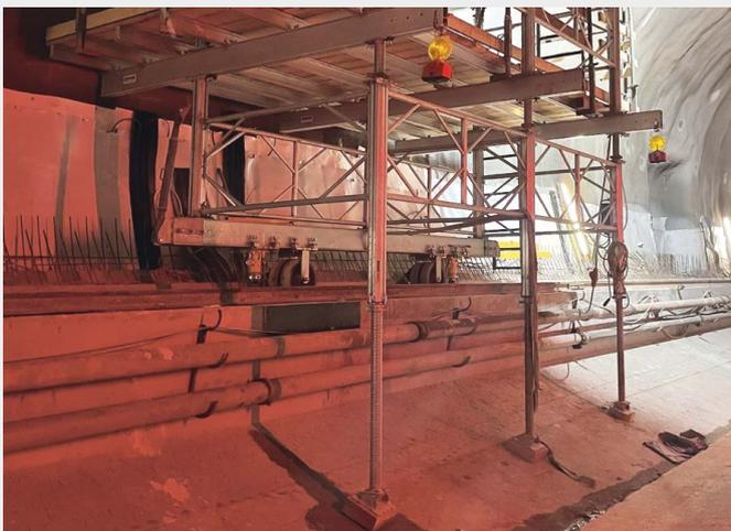
Zum Neigungsausgleich wurden bewegliche Platten am Fuß der Alu-Spindelstütze TITAN befestigt.
