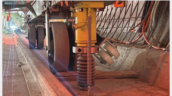
Mit Bockrollen-Fahrwerken und Hydraulik-Spindelhebern wurde das Alu-Schalungsgerüst TITAN fahrbar gemacht.
