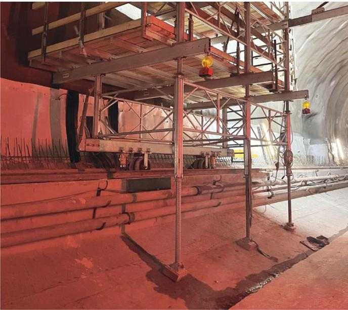
Zum Neigungsausgleich wurden bewegliche Platten am Fuß der Alu-Spindelstütze TITAN befestigt.
