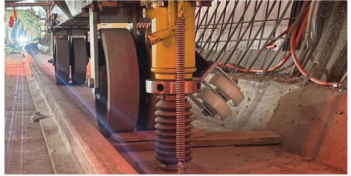
Mit Bockrollen-Fahrwerken und Hydraulik-Spindelhebern wurde das Alu-Schalungsgerüst TITAN fahrbar gemacht.
