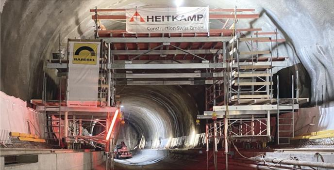
Zur Vervollständigung der Tunnel-Außenschale wurde ein Nachbearbeitungswagen von Ischebeck eingesetzt.
