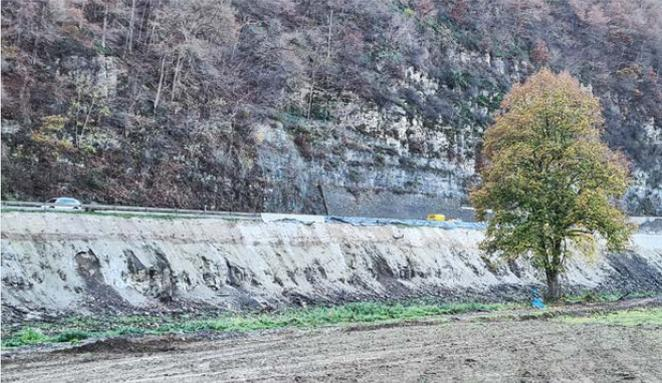
Auf einer Länge von ca. 400 m wurde eine Rückverankerung zur Böschungssicherung durchgeführt.
