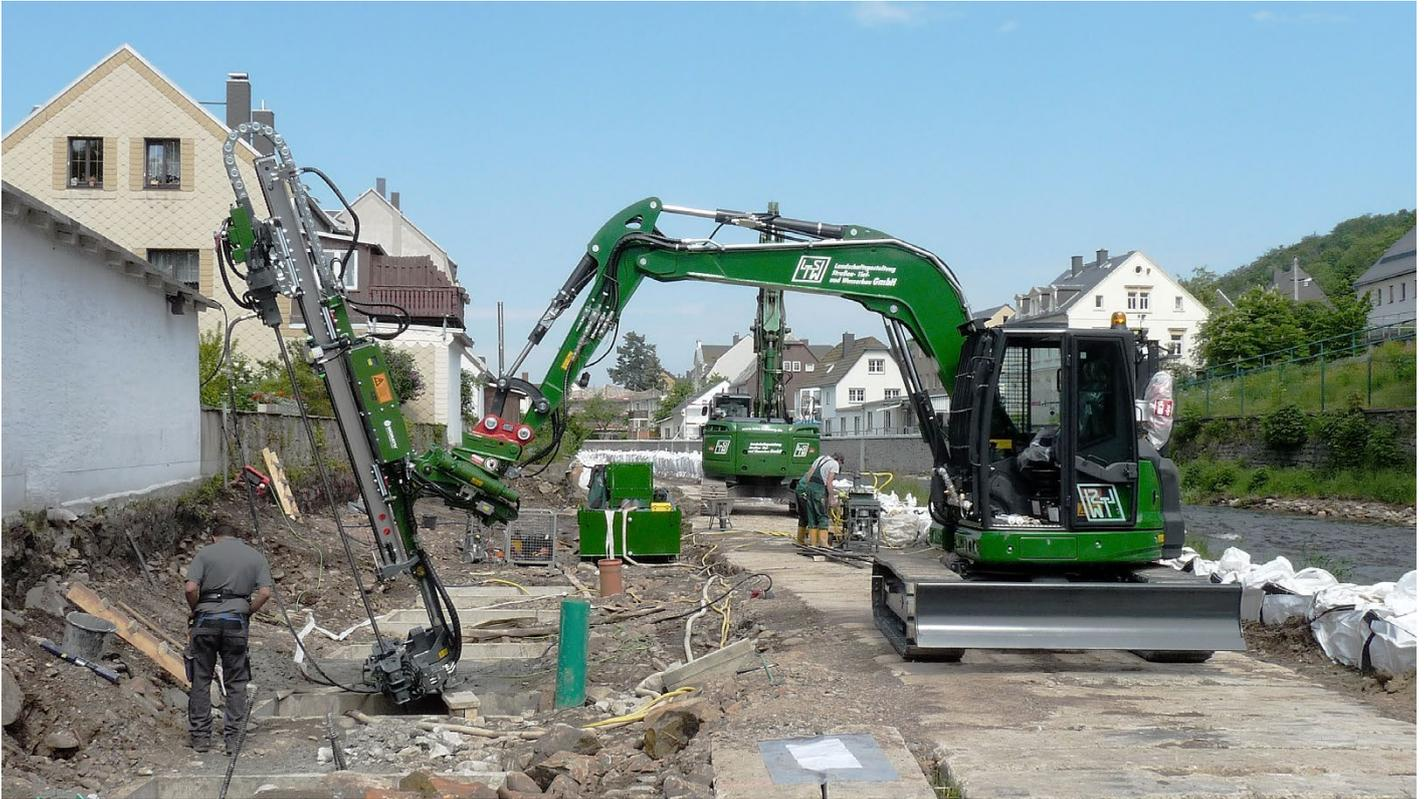
Zur Gründung von Fundamenten für neue Stützwände kamen im aktuellen Abschnitt Ischebeck Mikropfähle TITAN 40/16 und TITAN 52/26 zum Einsatz.
