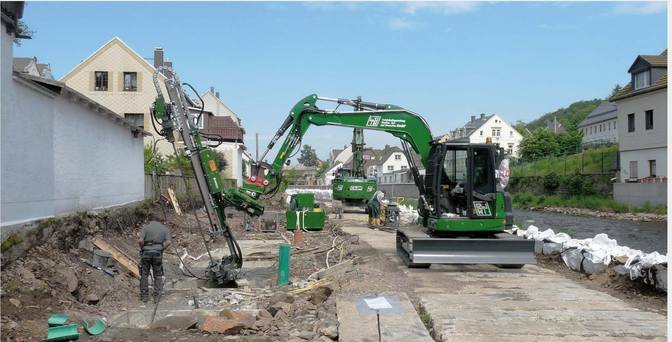
Zur Gründung von Fundamenten für neue Stützwände kamen im aktuellen Abschnitt Ischebeck Mikropfähle TITAN 40/16 und TITAN 52/26 zum Einsatz.
