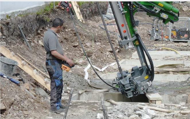
Mikropfähle TITAN sind mit DIBt-Zul. Z-34.14-209 für dauerhaften Einsatz (100+ Jahre) zugelassen.
