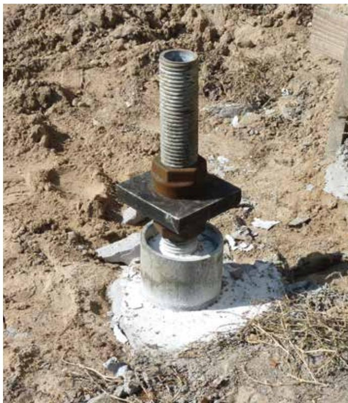
Die Zementstein-Überdeckung sorgt gemäß DIN EN 14199 für dauerhaften Korrosionsschutz.
