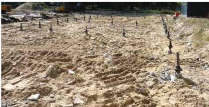
Im Zuge der Gründung einer Bodenplatte für den Kita-Neubau in Zehdenick wurden Mikropfähle TITAN 73/56 verwendet.
