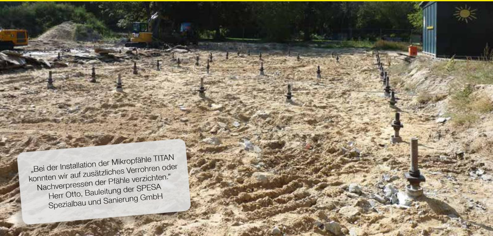
„Bei der Installation der Mikropfähle TITAN konnten wir auf zusätzliches Verrohren oder Nachverpressen der Pfähle verzichten.“
