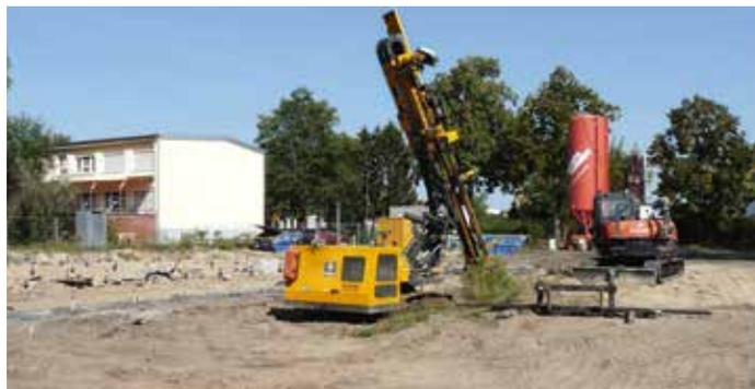
Der Einbau hat mit Hilfe eines Bohrwagens stattgefunden, der die Mikropfähle TITAN zielgenau installierte.
