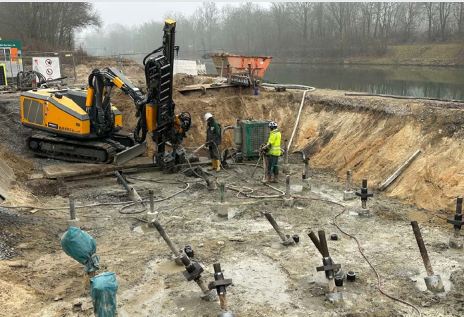
Die Mikropfähle wurden in einem statisch optimierten Raster zur Lastabtragung angeordnet.
