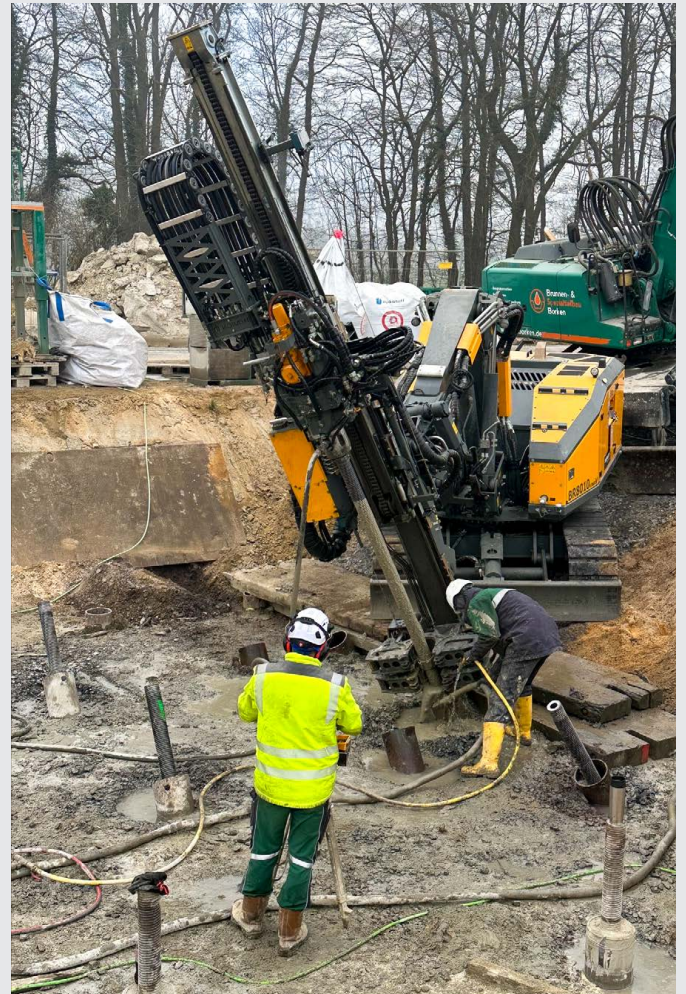
Einbau eines Mikropfahls mit dem Selbstbohrsystem TITAN. Bohren und Verpressen erfolgen in einem Arbeitsschritt.
