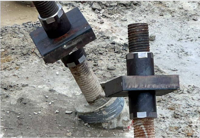
Vertikale und geneigte Mikropfähle sichern das Widerlager gegen Druck- und Horizontalkräfte.
