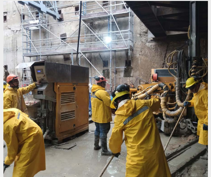
Effiziente und koordinierte Durchführung der Bauarbeiten durch das Bauteam.
