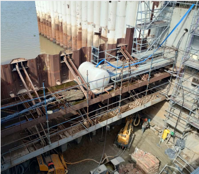
Arbeitsbereich begrenzt durch eingebrachte Spundwand und Baugrubenwand.
