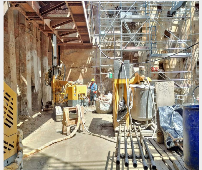
Beengter Bohrbereich mit bereitstehenden Bohrgeräten und bereitliegenden Teilen eines Mikropfahls.
