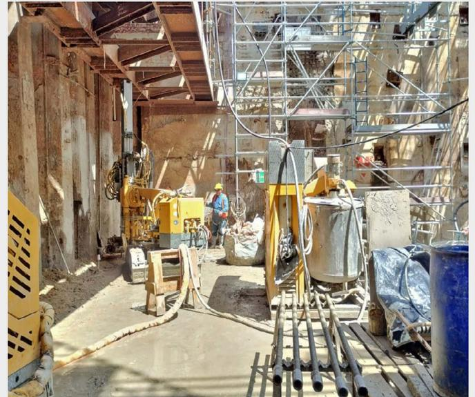
Beengter Bohrbereich mit bereitstehenden Bohrgeräten und bereitliegenden Teilen eines Mikropfahls
