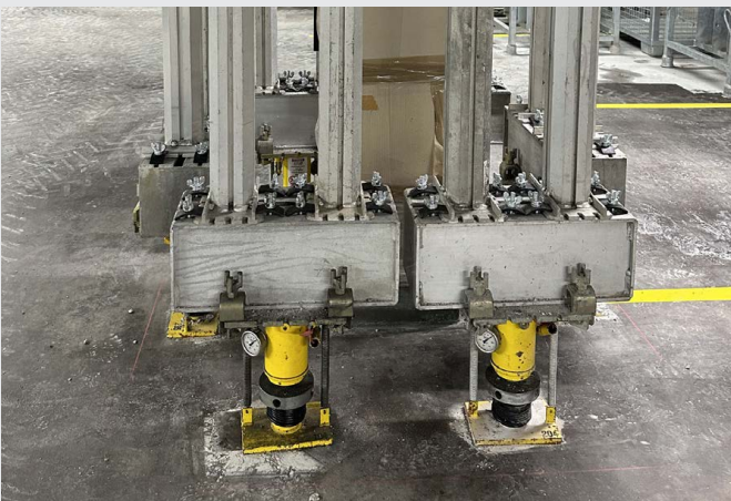
Exakte Vorspannung mit voller Kontrolle über das Manometer.
