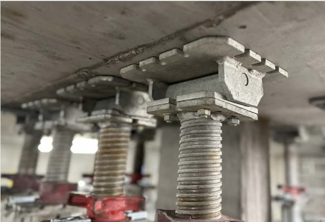
Sichere Fixierung auch an Deckenschrägen durch bewegliche Kopfplatten (Sonderanwendung).
