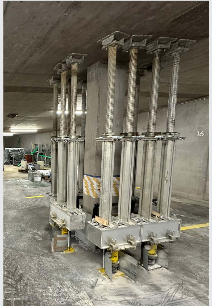
Temporäre Abstützung mit Schwerlaststützen TITAN SLS während der Sanierung von Tiefgaragen-Säulen.
