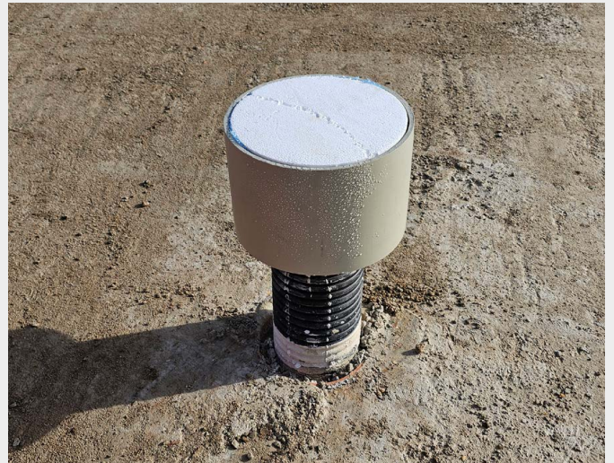
Eine Styroporhaube ermöglichte die Setzung der Bodenplatte, ohne die Druckkräfte auf die Mikropfähle zu übertragen.
