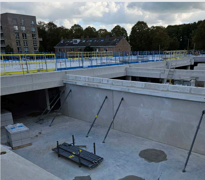
Überblick über die Fertigteilwände im Untergeschoss.
