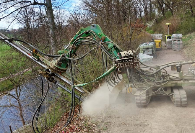
Der Einbau der Mikropfähle TITAN erfolgte mit kleiner Gerätetechnik, zwischen und neben zu erhaltenden Gehölzen.
