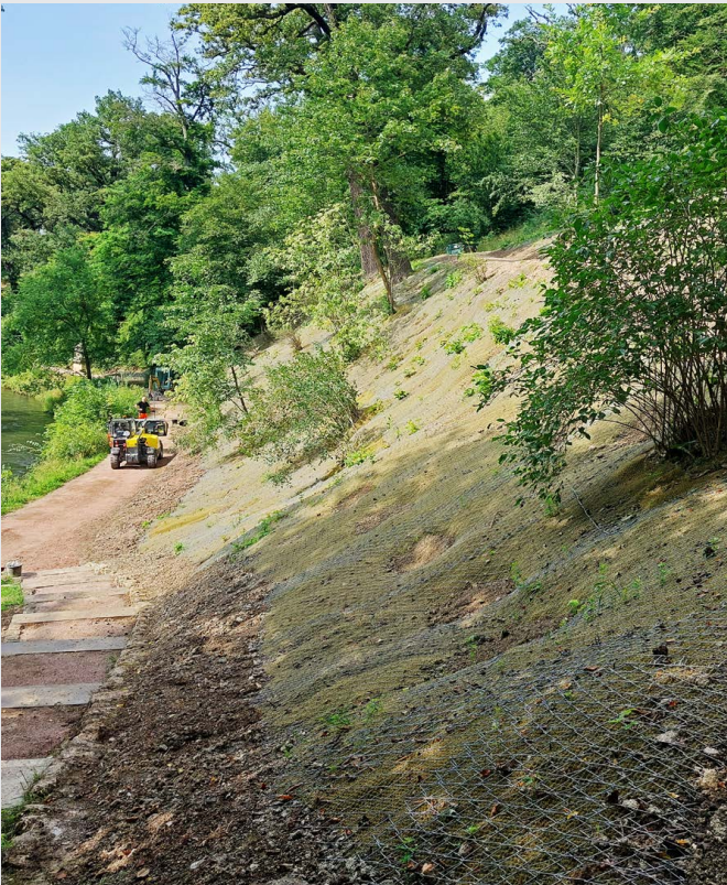
Fertiggestellte Hangsicherung mit bereits wieder durchtreibender Vegetation (Mai 2025).
