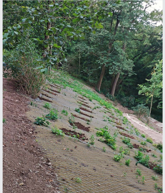
Die Kopfkonstruktion der Bodennägel wurde in Vertiefungen gesetzt, die anschließend mit Mutterboden aufgefüllt wurden.
