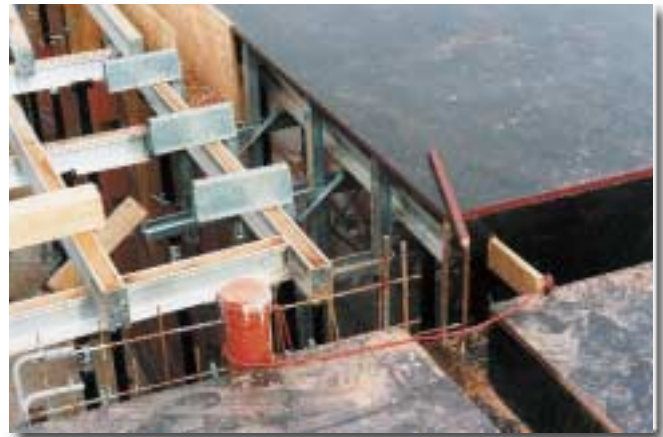
Bewehrungs-Korb aus Längsseisen und Bügeln über der Unterzugschalung flechten, mit Abstandhaltern versehen und absenken.
