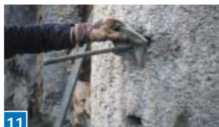
8 Hilfsrohr abnehmen, dafür Gegenplatte, Hilfsrohr und 2. Gegenplatte auf Spannstahl schieben.
