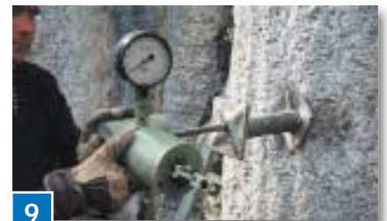
6 Hilfsrohr 34 mm Außendurchmesser (Wasserleitungsrohr 1") auf Spannstahl schieben.
