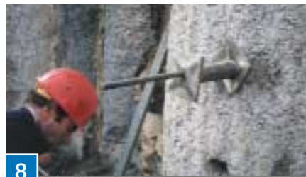
5 Betonanker mit Spannstab zum Grund des Bohrlochs schieben.
