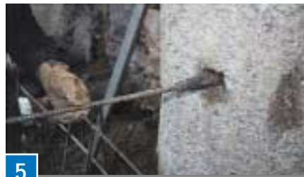
2 Bei wenigen und häufig noch waagerechten Bohrungen lässt sich meistens nur eine handgeführte Schlagbohrmaschine mit hartmetallbestückter Bohrkronen und Zentrierspitze einsetzen. Nachteilig ist der hohe Kraftaufwand zum Halten und Anpressen, die Staubentwicklung, die Zahl der Fehlbohrungen wegen Armierungseisen und die unrunde Bohrung.
