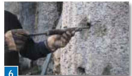
3 Das Bohrloch muss mit einem Kratzer, der mit Putzwolle umwickelt ist, von Bohrmehl gründlich gesäubert werden. Wegen möglicher Rückstände von Bohrmehl sollten Felsanker immer so eingesetzt werden, dass die Klemmbacken waagrecht liegen.
