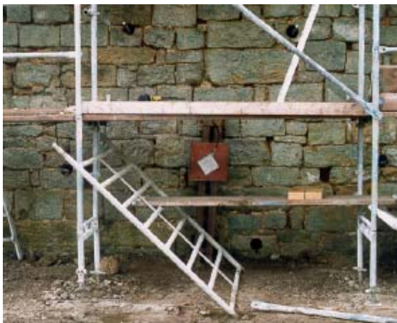
Probebelastung des Bodennagels
