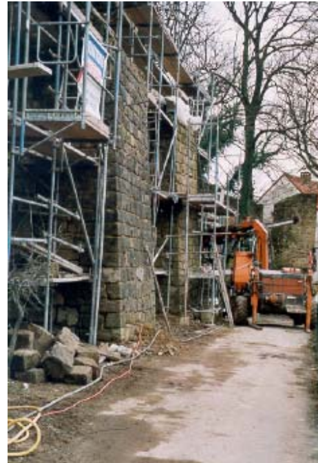
Auskern ca. 150 mm Ø Bodennagel TITAN 30/11 bohren und dynamisch verpressen
