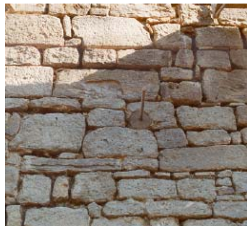
Einsetzen des Bohrkerns und Abschneiden des luftseitigen Endes des Bodennagels
